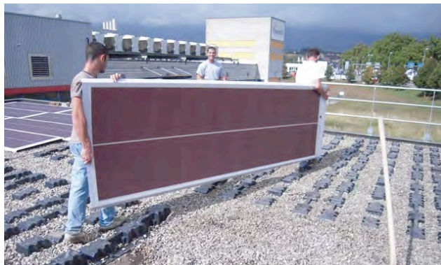
Installation aisée des modules, légers et flexibles
