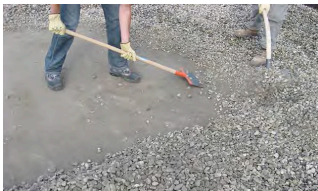
Elimination du gravier ; mise à nu de la membrane
