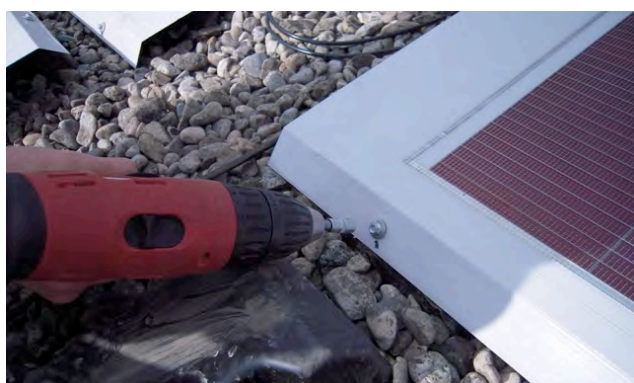
Fixation mécanique du module sur son support, par vis autoforantes
