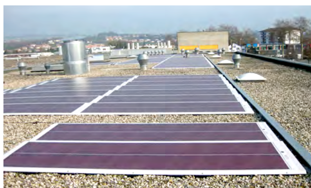
Installation aisée des modules, légers et flexibles
