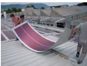
Montage aisé et connexion rapide avec fiches IP65
